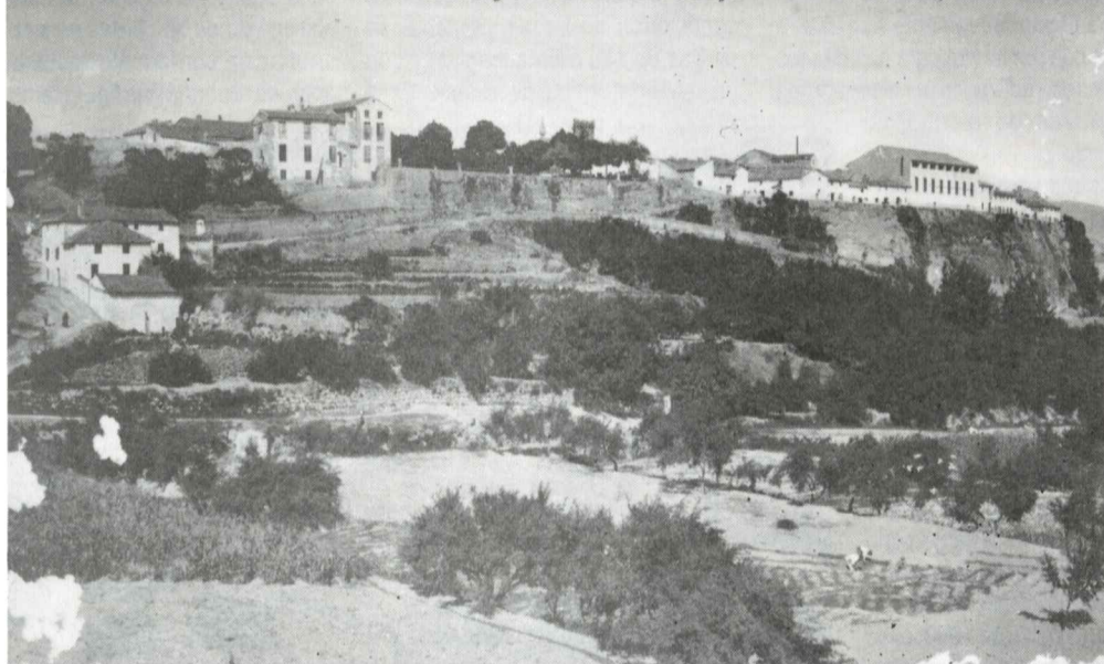
N.º 8317. - PRIEGO. — Vista del Adarve y Paseo desde abajo
