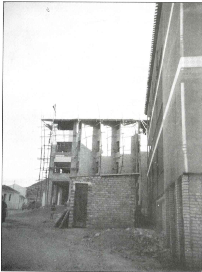
Inicio de las obras. Año 1969.
