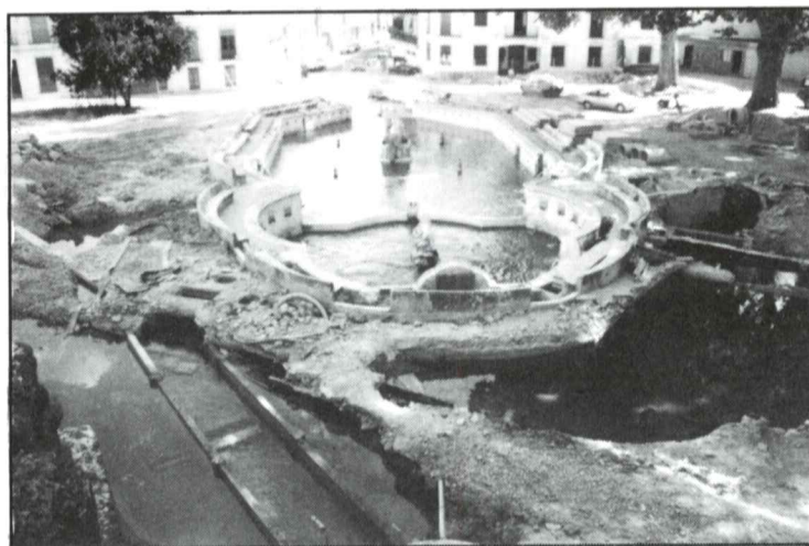
Obras con motivo del saneamiento del subsuelo en la Fuente del Rey, 1997.
