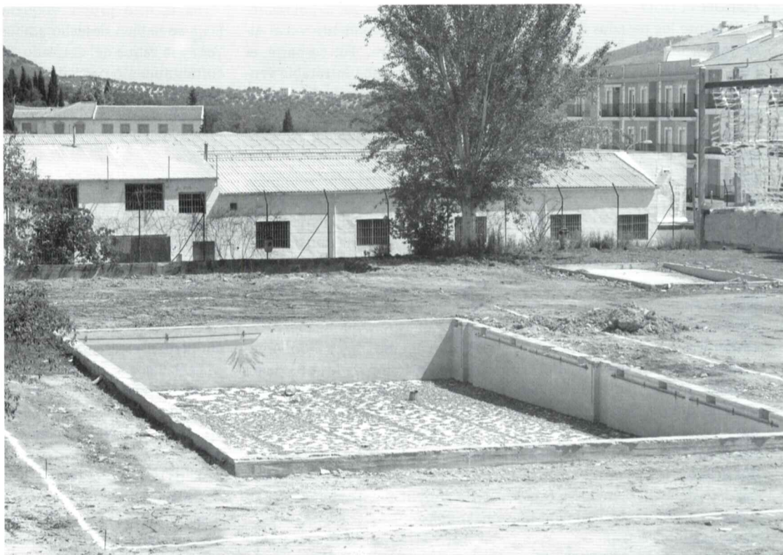
Estado actual de las antiguas instalaciones de la piscina municipal donde han comenzado las obras.
