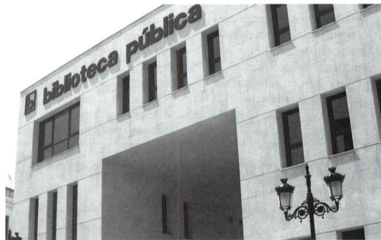
Nuevas instalaciones de la biblioteca pública
