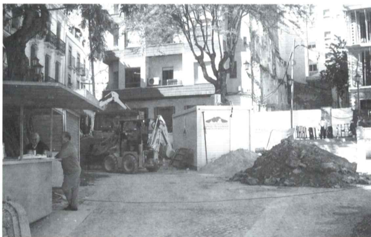
Obras en las inmediaciones de la Plaza San Pedro
