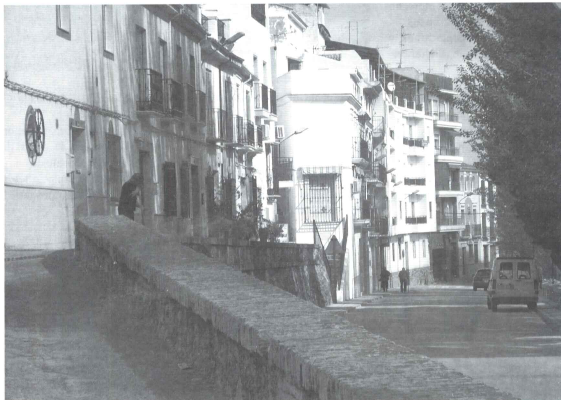
Calle Cervantes una de las cuatro obras de mayor presupuesto con fondos estatales
