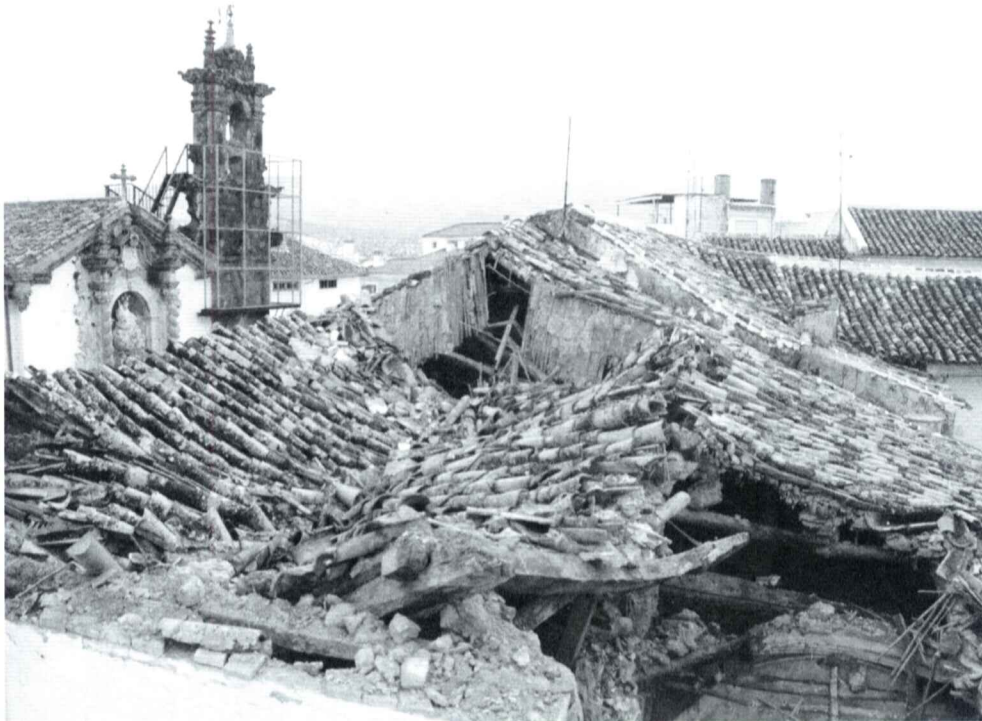
Hundimiento del tejado de la casa nobiliaria de "Los Vallejo" en la Carrera de Álvarez
