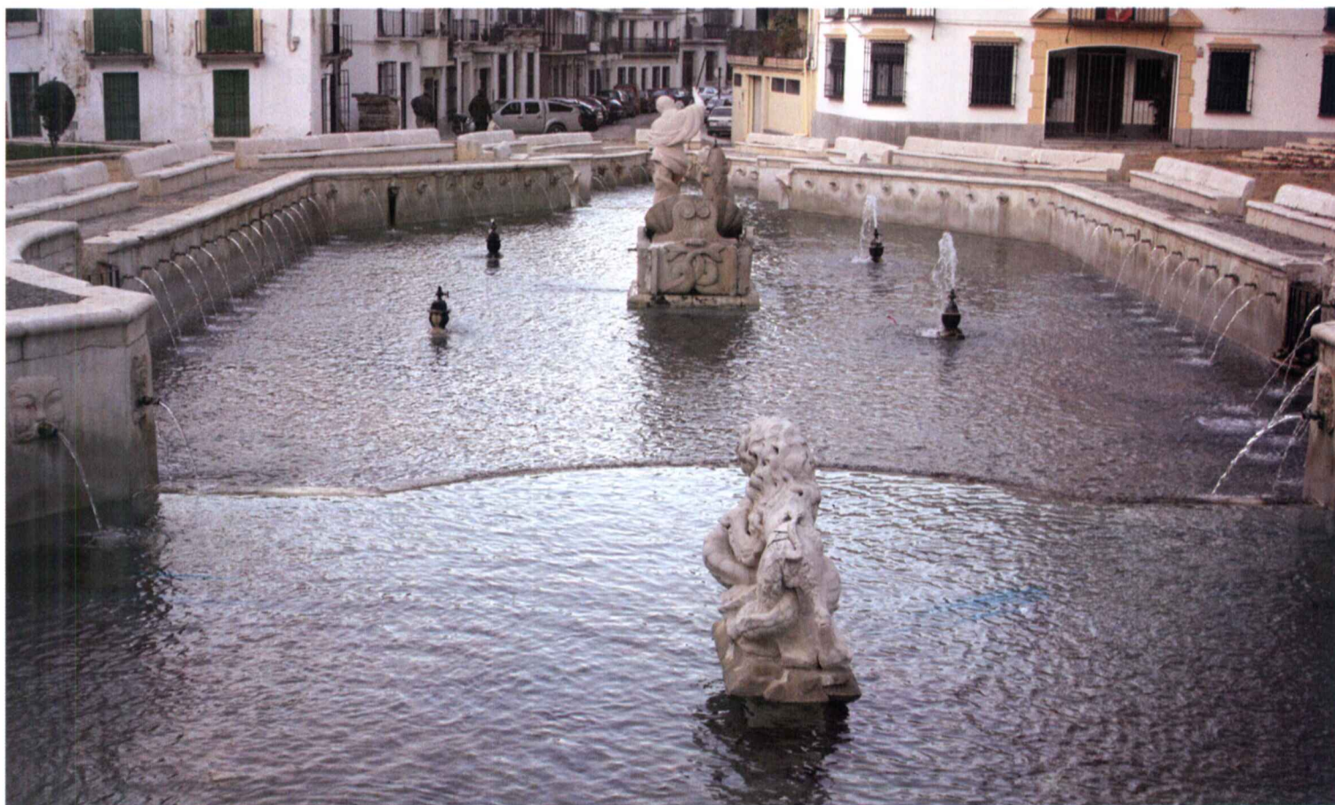
La fuente del Rey de Priego de Córdoba, santo y seña del agua de la ciudad, vista desde la Fuente de la Salud
